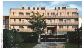
† Résidence 'Hester' à Rosny-sous-Bois (93), un immeuble de 19 logements en structure bois (BM, BLC et CLT). Maître d'ouvrage : RE Habitat ; maître d'œuvre : Archi 5.
